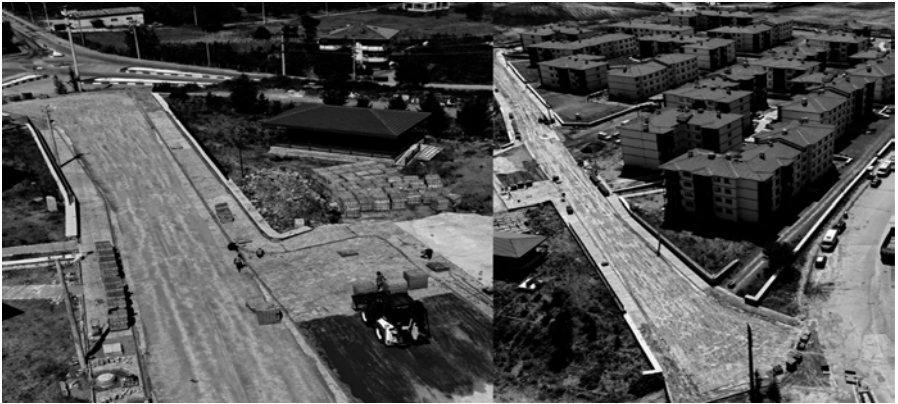
Görsel 3. Düzce Umut Evleri Konut Yapı Kooperatifi, Beyköy, Düzce. (Düzce Gündem Haber, 2025)
